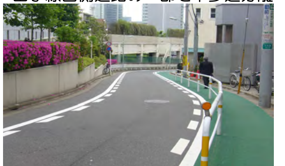
山手線西側道路の一部を車歩道分離
