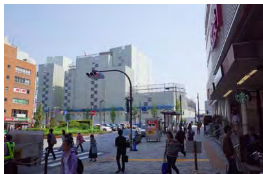
解体工事開始時の駅前
